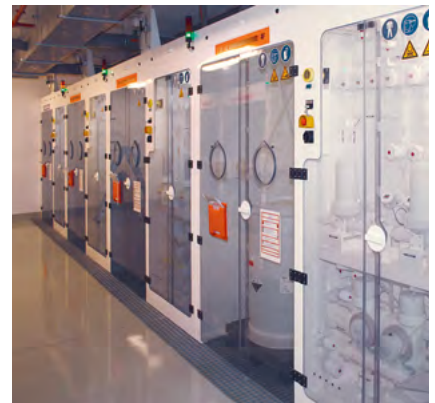
Chemieversorgungssysteme mit Türen aus SIMONA® PVC-GLAS
