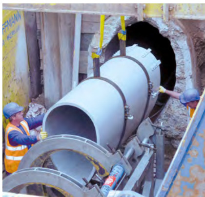
Sanierung eines Abwasserkanals mit SIMONA® PE 100 hellgrau Eiprofilen
