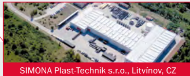
SIMONA Plast-Technik s.r.o., Litvinov, CZ
