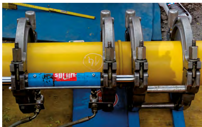
Verschweißen einer SIMONA® PA 12 Gasleitung
